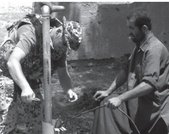
Bewässerungssysteme sind vielerorts im Krieg zerstört worden. Ein Pionier der Bundeswehr leistet Hilfestellung bei der Brunnenreparatur. Ist das eine militärische Aufgabe? Foto: Redaktion Einsatz Bundeswehr
