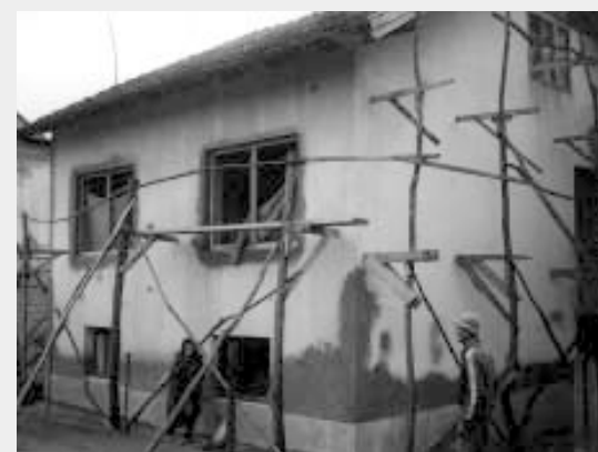
Wiederaufbau: Familie Krdzalic setzt neue Fenster in ihr Haus ein. Foto: Büro Zenica
