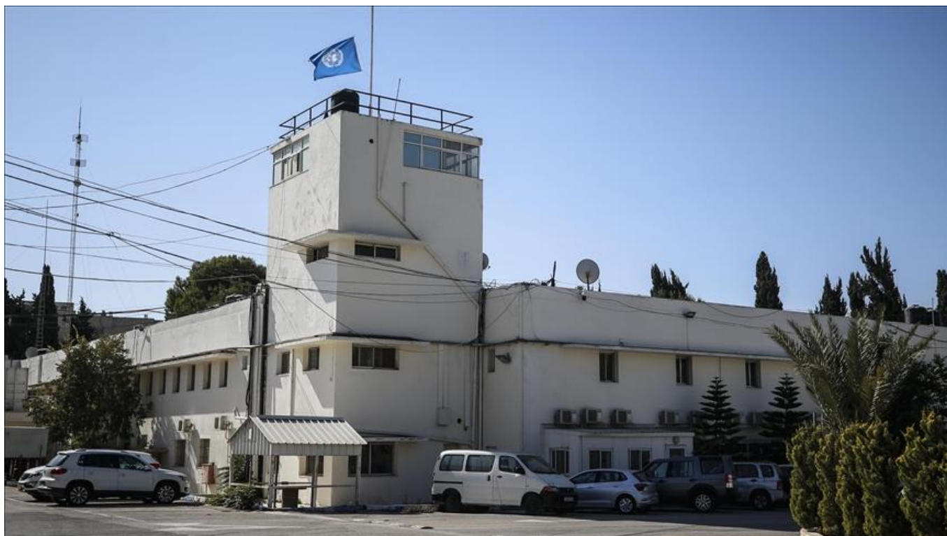
UNRWA-Verwaltungskomplex in Sheikh Jarrah vor der Zerstörung ...
